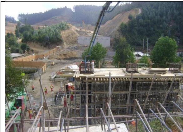
Hormigonado Columnas 1-2-3 Cepa N° 3 Tramo A II Sector By Pass Laraquete Viaducto las Cruces km: 44. 429,40.
