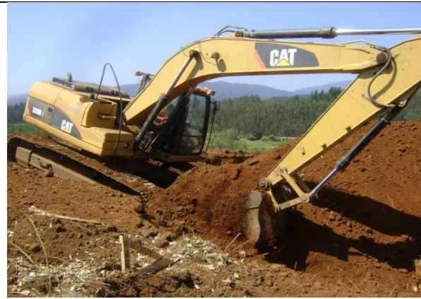
Movimiento de Tierra Retaluzado Terraza N°1 Corte Sector Cementerio Tramo A Sector II Lado Derecho km: 58.120-58.300.
