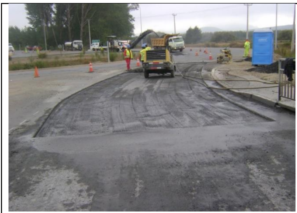
Fresado y Reparación de Pavimentos Deteriorados Eje N° 107 Tramo A Sector II Enlace celulosa Arauco Lado Derecho km: 0,200 – 0,224.
