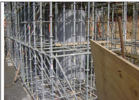
Instalación Moldajes y Cimbra para Dintel Cepa N°3 Viaducto las Cruces Tramo A Sector II By Pass de Laraquete, km: 44.429,40.
