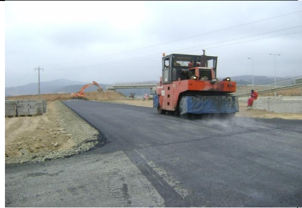
Colocación de Binder Sector Área de servicio Tramo A Sector II By Pass de Laraquete Eje N°95 km: 0,010 – 0,085.
