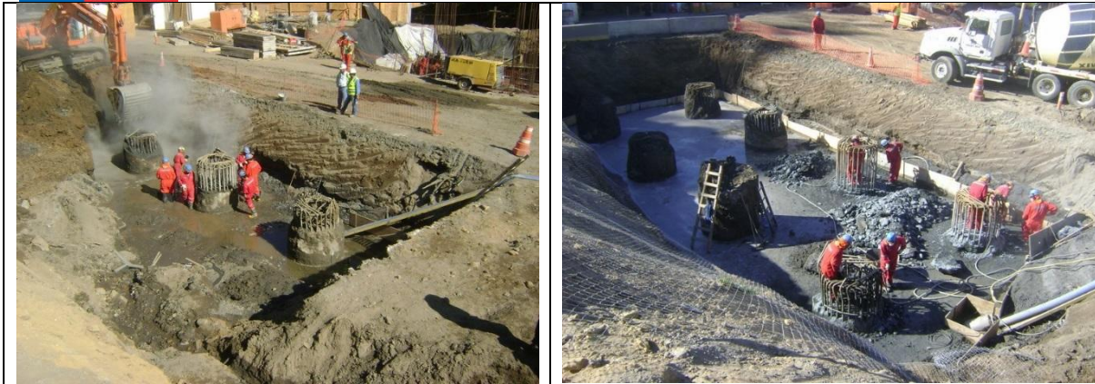
Descabezado Pilotes N°1-2-3-4-5-6-7-8 Cepa N°1 Viaducto las Cruces Tramo A Sector II lado Izq/der By Pass de Laraquete km: 44. 353,1.
