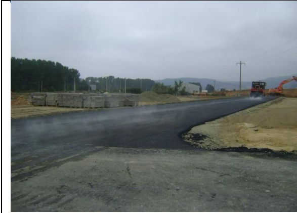
Colocación de Binder Sector Área de servicio Tramo A Sector II By Pass de Laraquete Eje N°95 km: 0,010 – 0,085.
