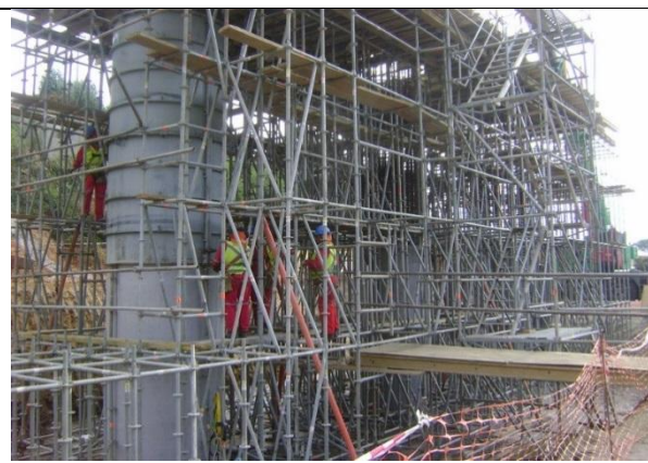
Instalación Moldajes y Cimbra para Dintel Cepa N°3 Viaducto las Cruces Tramo A Sector II By Pass de Laraquete, km: 44.429,40.
