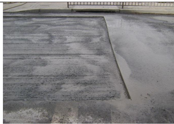
Fresado y Reparación de Pavimentos Deteriorados Eje N° 107 Tramo A Sector II Enlace celulosa Arauco Lado Derecho km: 0,200 – 0,224.
