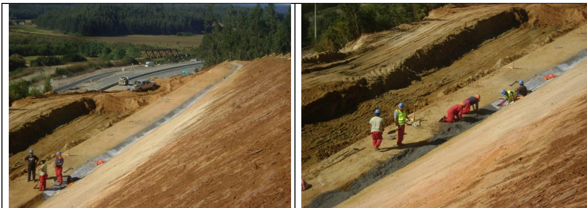
de Cuneta en Terrazas N°2 Corte Retaluzado sector Cementerio Tramo A Sector II km: 58,120-58,300.
